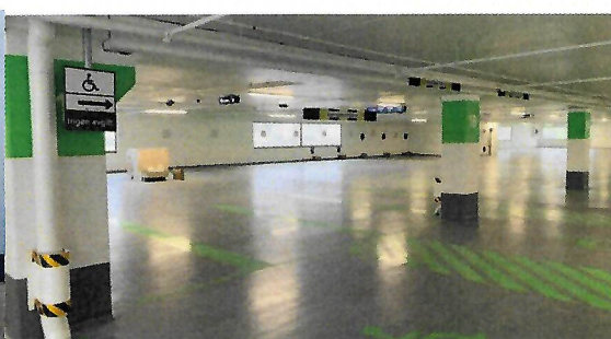
Innvendig Rossmolla P-hus
