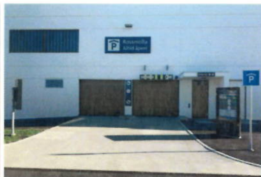
Innkjøring til Parkeringshus Rossmolla
