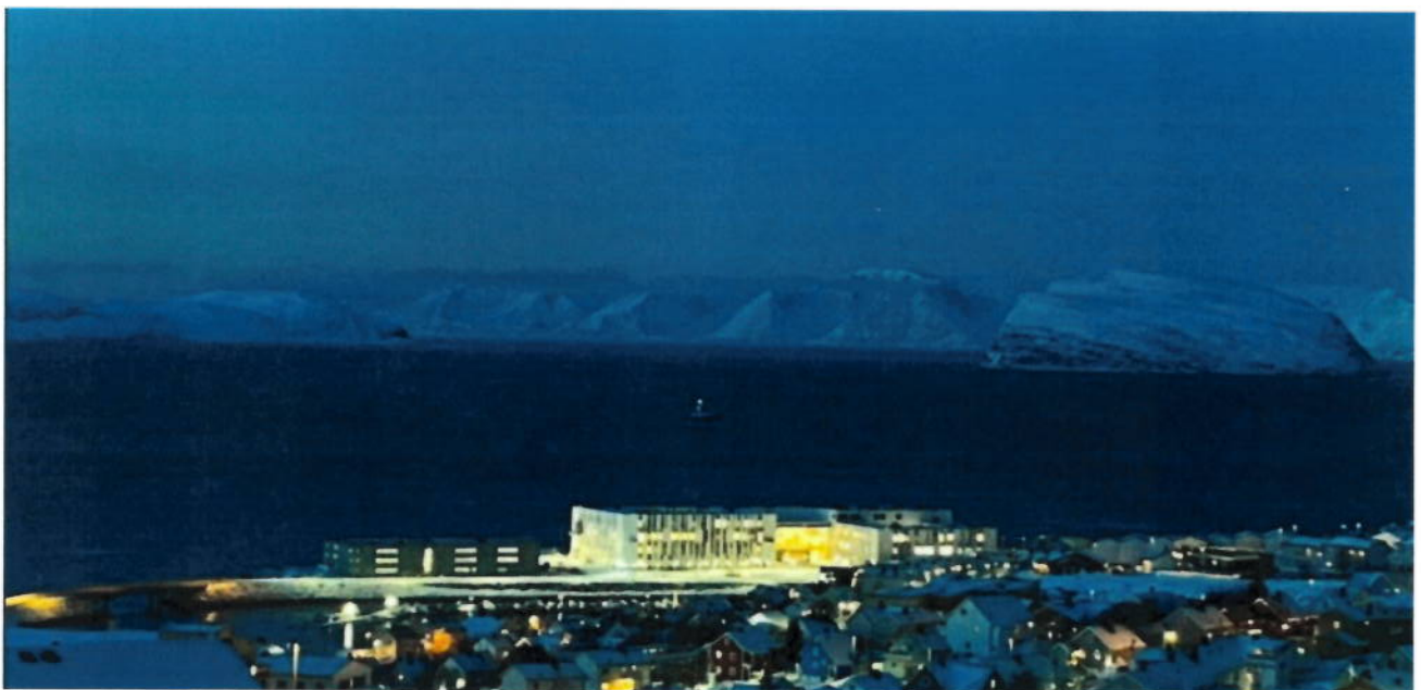
Parkeringshus under oppføring ved nye Hammerfest Sykehus
